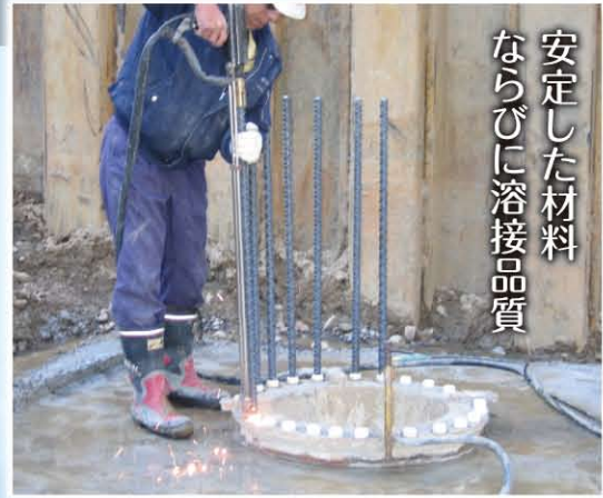
SC-PSW溶接工法
